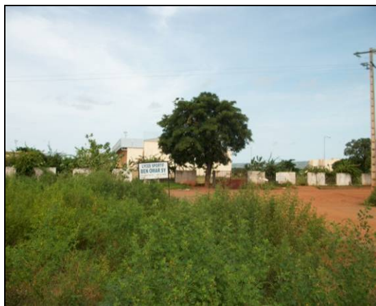
Photo 2 : emprise de la conduite de refoulement
