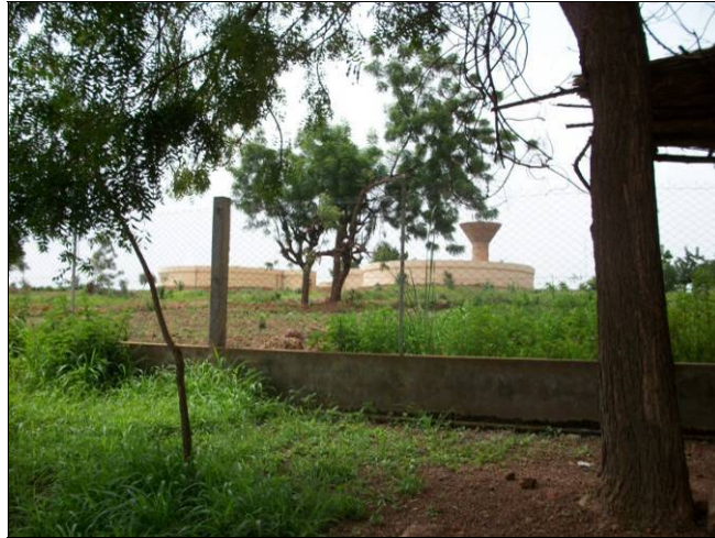
Photo 7 : Site des réservoirs de Badalabougou
