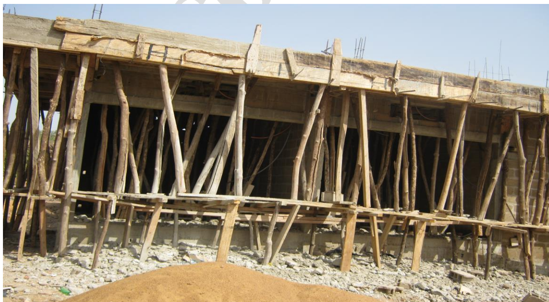
Immeuble en construction sur le site convoité de N'Tomikorobougou
