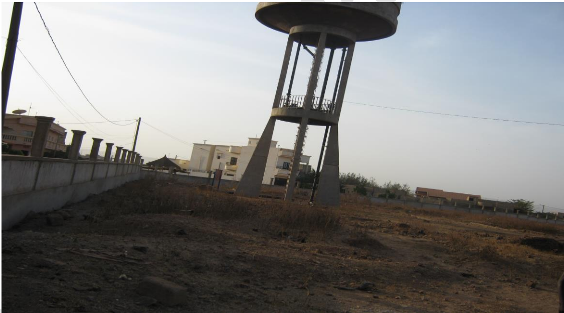
Site de la SOMAPEP sécurisé par un mur de clôture
