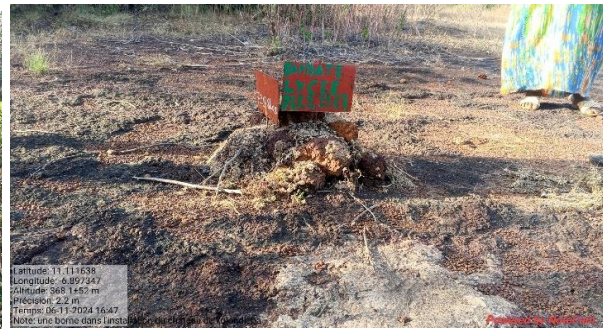
Photo 2: Limite d'une concession sur le site du château d'eau
