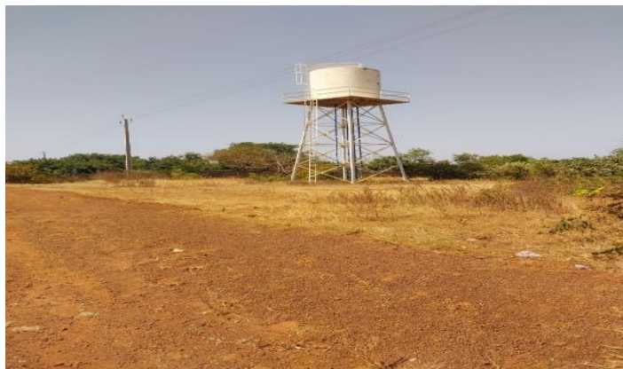
Photo 2 : Aperçu de l'ancien château sur le site du nouveau château de 500m 3 à réaliser
