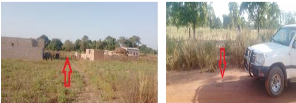
Photo 8 : A gauche : point de passage de la conduite de refoulement eau brute entre deux concessions dans la zone de lotissement Est de Tétoubougou
